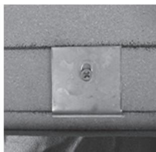
写真 3.1 受け金物の下地への固定例
